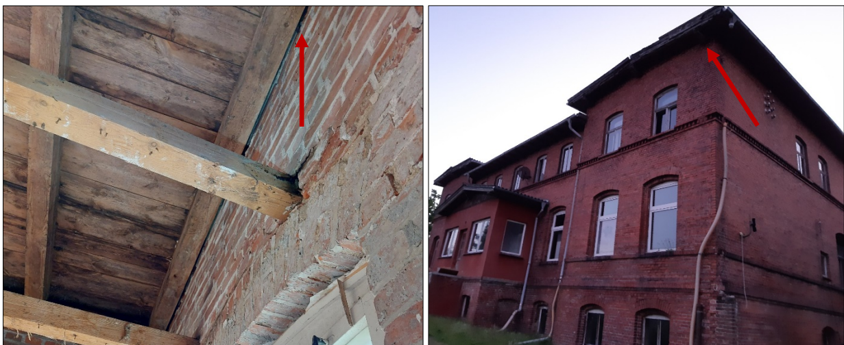
Abbildung 8: Zwergfledermausquartier hinter dem Dachbalken im Gutshaus und Einflugsort am Gutshaus
