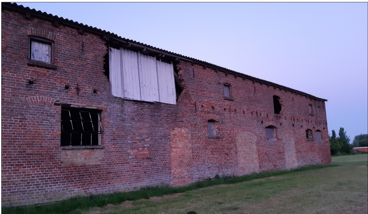
Abbildung 10: Südseite des Pferdestalls mit Ein- und Ausflugmöglichkeiten für Fledermäuse
