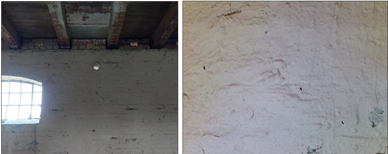
Abbildung 11: Innenwand des Pferdestalls mit Kotkrümeln von Zwergfledermäusen
