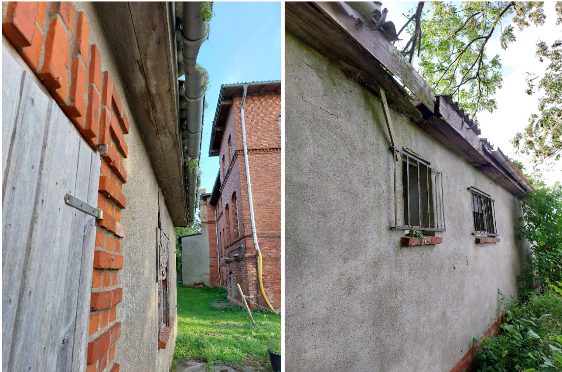
Abbildung 12: Außenansicht ehemaliges Konsumgebäude
