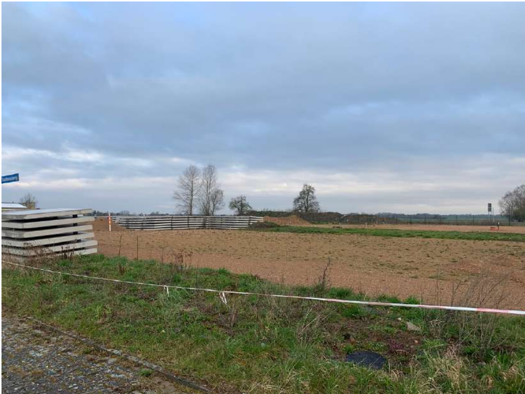
Abb. 4: Baustelle im östlichen Teil des Untersuchungsgebietes, März 2023
