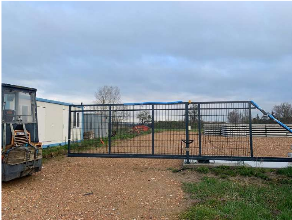
Abbildung 5: Baustelle auf Flurstück 74 (Blick von Süd nach Nord) (März 2023)
