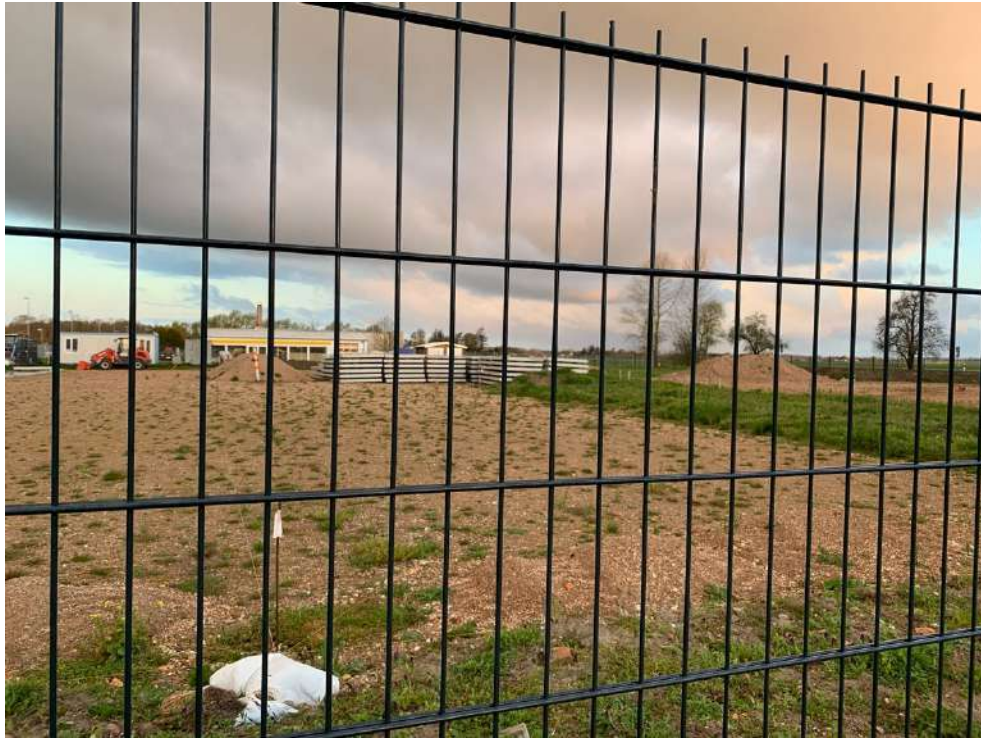
Abbildung 7: Baustelle innerhalb von Flurstück 74, Blick von Ost nach West (März 2023)
