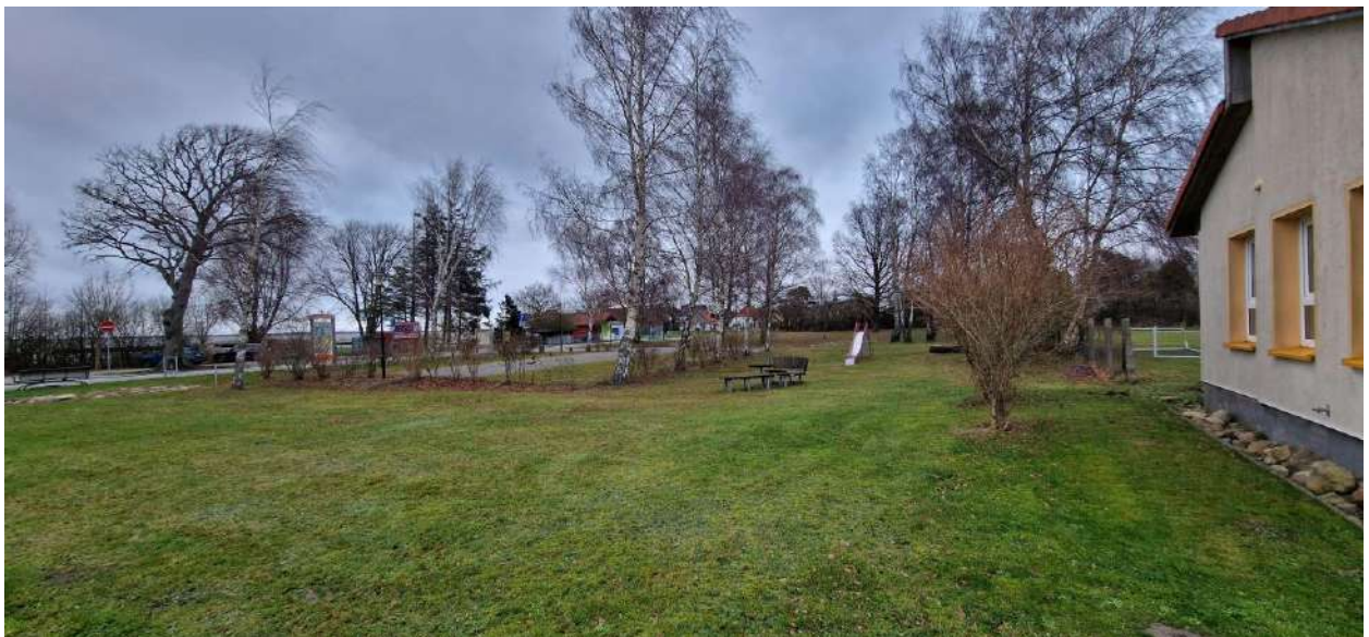
Abbildung 10: Blick aus südwestlicher Richtung, rechts ist der untersuchte Gebäudeteil zu erkennen.
